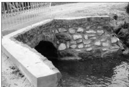
Během posledních dvou měsíců se v obci událo plno věcí. Jednou z nich byla i oprava mostu v osadě Mezihorská. Na obrázcích můžete srovnat stav mostu před opravou a v současné době.
