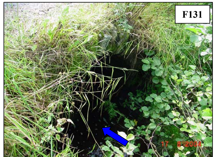
Koryto Chodovského potoka před kamenným mostem.
