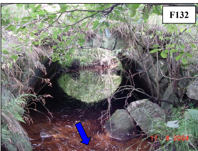
Pohled ze spodní části mostu.
