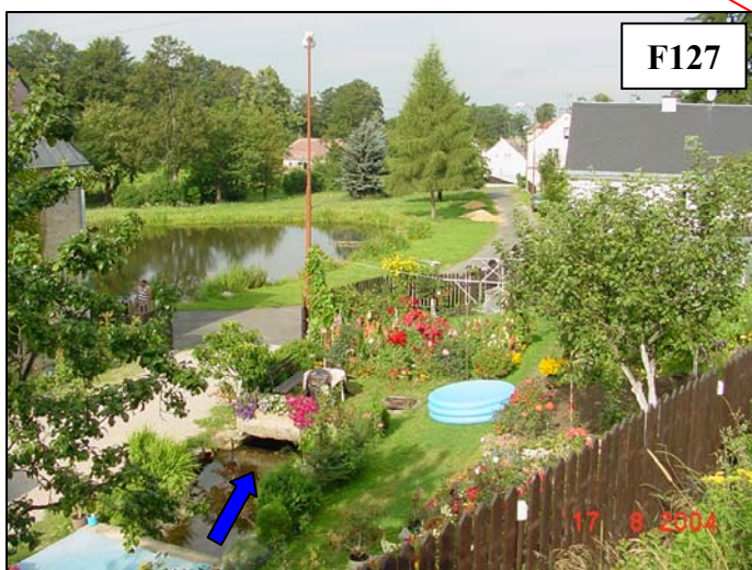
Pohled na zatrubnění potoka a požární nádrž u Surových.
