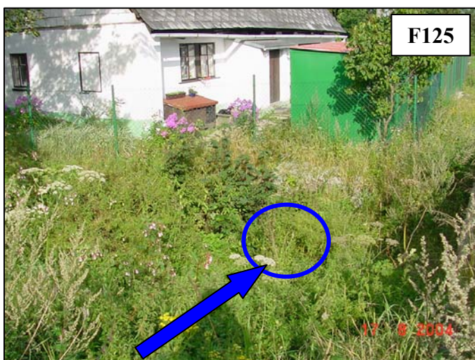
Začátek zatrubnění cca 30 m. Nebezpečí usazování plavenin a ohrožení objektu čp. 197.
