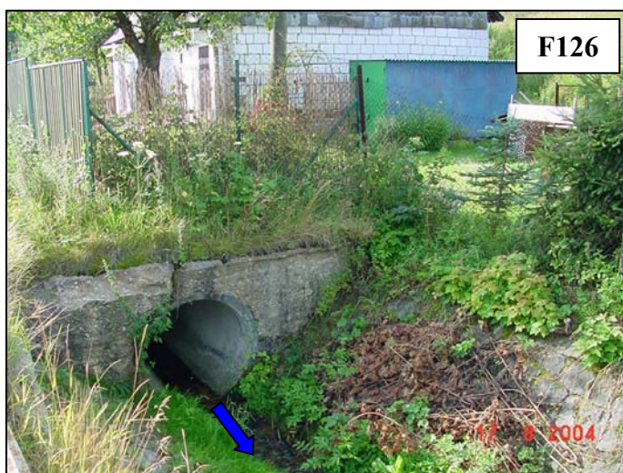
Vyústění zatrubnění (roura má průměr 1000 mm).
